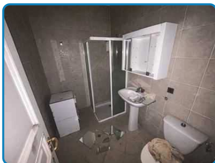
Villa n°2 Ouest Sous sol Sde WC n°3
