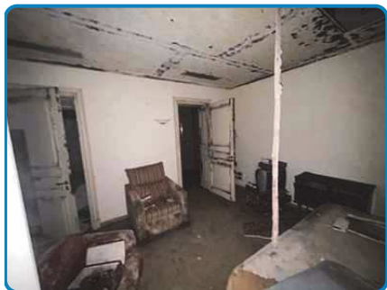
Villa n°2 Ouest Sous sol Chambre 4
