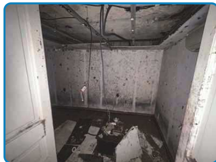
Villa n°2 Ouest Sous sol Chambre 5
