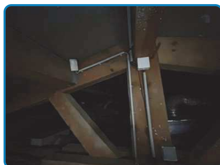
Villa n°2 Ouest Toiture Combles
