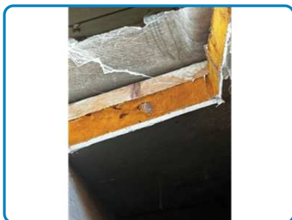
Villa n°2 Ouest Toiture Combles
