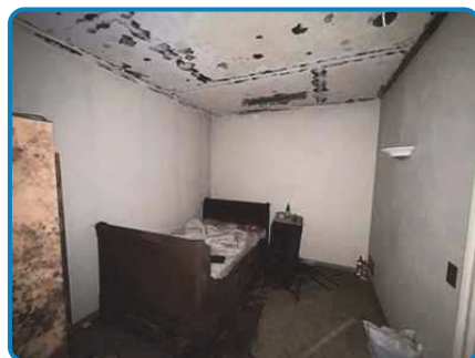
Villa n°2 Ouest Sous sol Chambre 3
