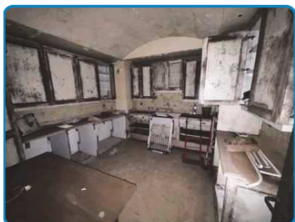
Villa n°2 Ouest Sous sol Cuisine n°2
