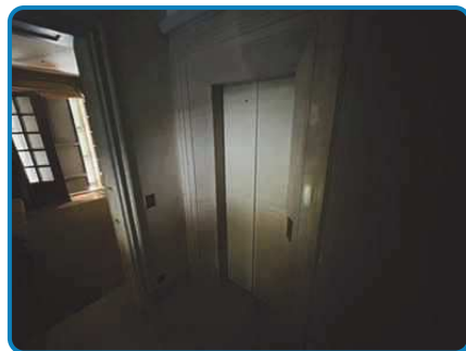
Villa n°2 Ouest 1er étage Dégagement 2
