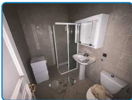
Villa n°2 Ouest Sous sol Sde WC n°3
