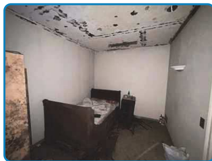
Villa n°2 Ouest Sous sol Chambre 3
