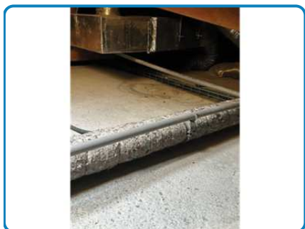
Villa n°2 Ouest Toiture Combles
