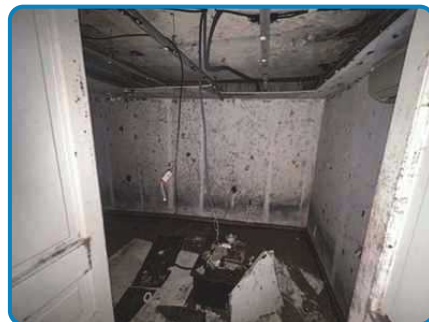
Villa n°2 Ouest Sous sol Chambre 5
