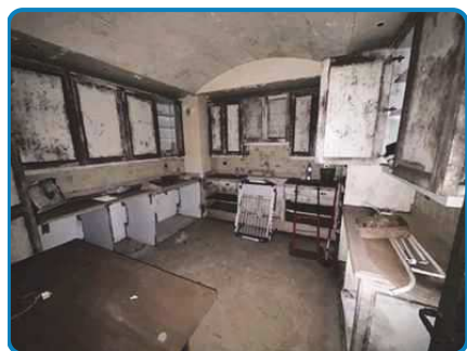
Villa n°2 Ouest Sous sol Cuisine n°2
