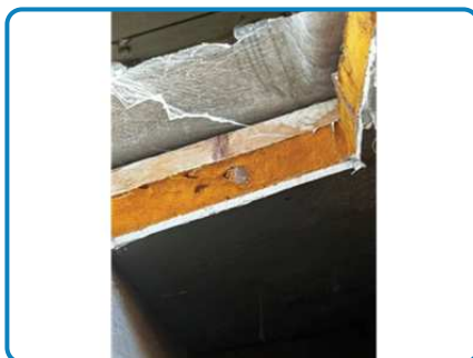
Villa n°2 Ouest Toiture Combles
