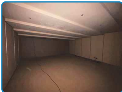
Annexe(s) Sous sol Salle de cinéma
