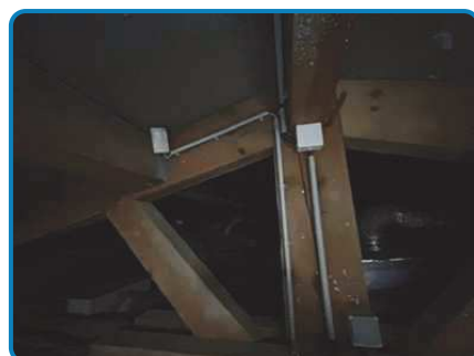
Villa n°2 Ouest Toiture Combles
