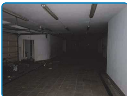
Villa n°2 Ouest Sous sol Garage
