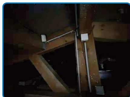
Villa n°2 Ouest Toiture Combles
