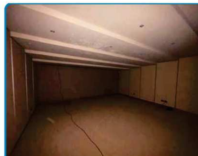
Annexe(s) Sous sol Salle de cinéma
