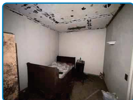
Villa n°2 Ouest Sous sol Chambre 3
