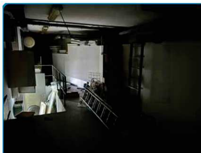
Annexe(s) Sous sol Vide sanitaire
