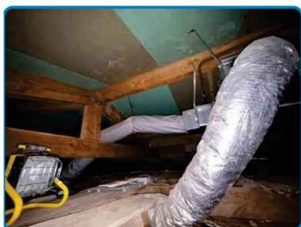
Villa n°1 Est Toiture Combles
