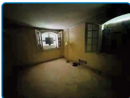
Villa n°2 Ouest 1er étage Chambre 1
