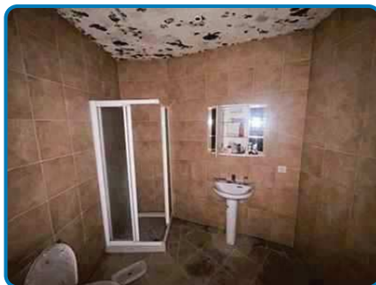
Villa n°2 Ouest Sous sol Sde WC n°4
