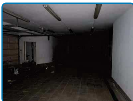
Villa n°2 Ouest Sous sol Garage
